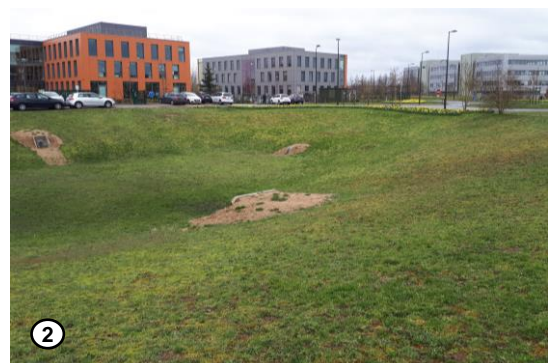
Bassin d'orage devant l'entreprise Axéreal
