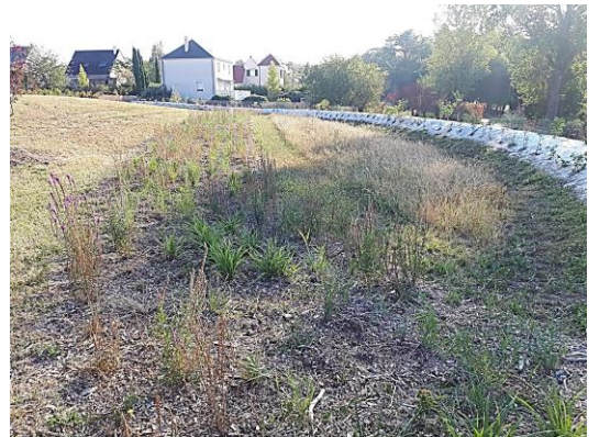
Bassin d'infiltration aménagé et végétalisé
