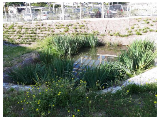
Bassin en eau de la résidence séniors
